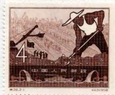
1163. volontaire travaillant au barrage
