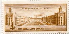
1097 Vue de l'usine de Changchun
