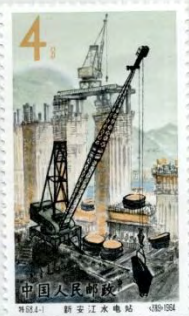
1590 grand barrage en construction
