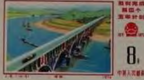
1266 (42007) Canal suspendu d'irrigation
